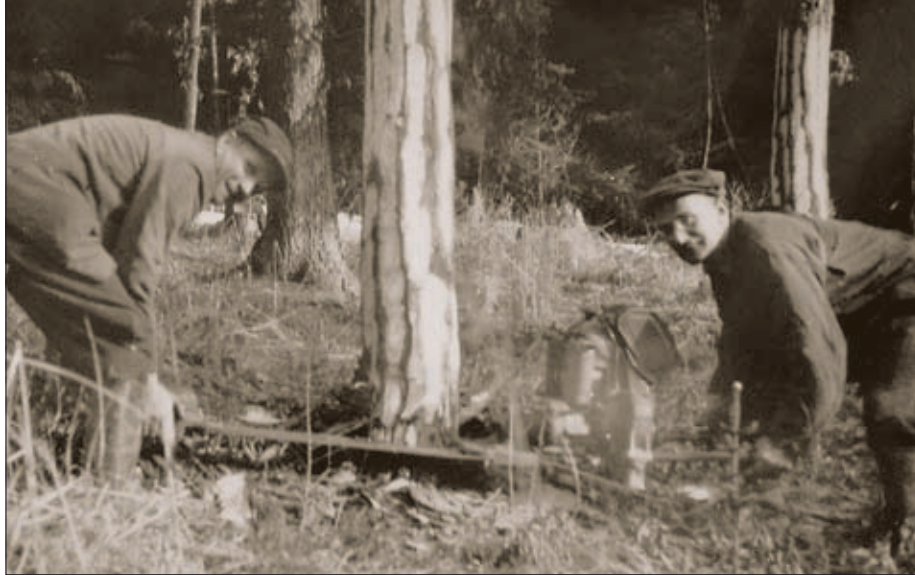
Dávno předtím, než se u nás začaly objevovat víceméně zdařilé kopie všeho možného z Číny, se v tehdejší Československu objevila velmi povedená kopie dvojmužné motorové pily STIHL, známá pod názvem MP 50.
